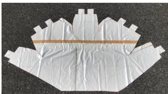
「写真1 型枠の切り出し」
